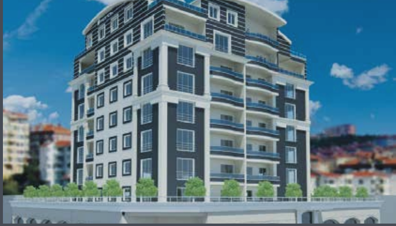
Konat İnşaat Bursa
